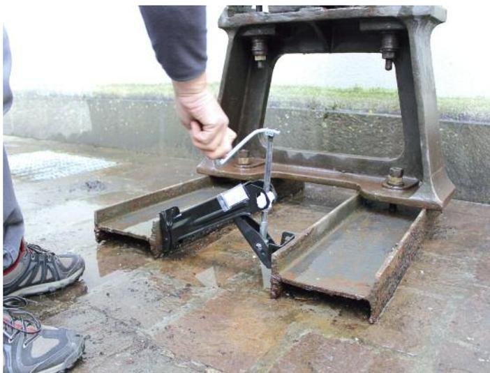
La struttura portante della Piccola Ruota viene controllata e regolata con l'aiuto di un cric da auto.
